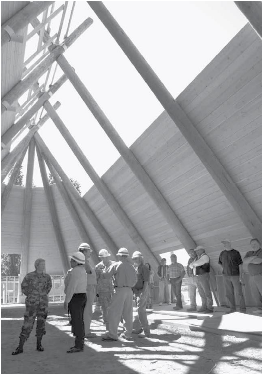
El Teniente general, Carl Strock, en el centro, con la cabeza a un lado, observa los trabajos de construcción que se están realizando en la nueva casa comunal en la aldea Celilo. Strock hizo dos visitas a la aldea mientras se construía la casa comunal y habló extensamente con los líderes de las tribus sobre el proyecto.
