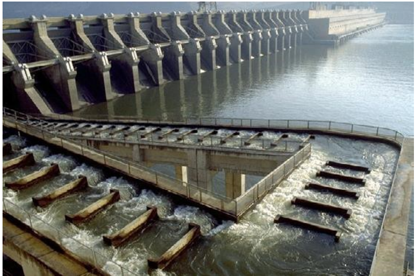
Los peces nadan por una serie de escalones para atravesar la presa.
